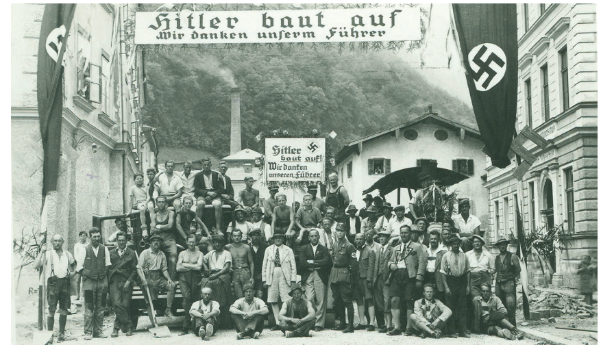
Dieses Propagandafoto zeigt vor einer Straßenbaustelle in Hallein Bauarbeiter, aber auch SA-Männer und in der Mitte den Bürgermeister Alexander Gruber als Symbol der Volks-gemeinschaft , die angeblich die Losung „Arbeit und Brot für alle“ verwirklichen könne. © Keltenmuseum Hallein/Stadtarchiv.
