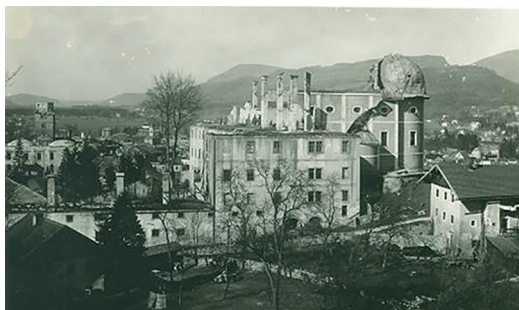
Die Brandruine auf dem Georgsberg befand sich in einem Zustand, dass sie nach heutigen Gegebenheiten wieder instand gesetzt worden wäre.
