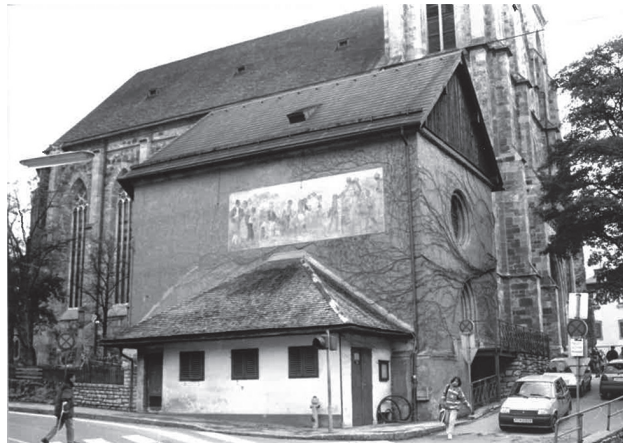
Die Annakapelle mit dem Kiosk aus dem Jahr 1994. © Bauuntersuchung im Untergeschoß der Annenkapelle von St. Johann im Pongau von Rudolf Koch , Wien vom Oktober 1994 mit beigelegten Abbildungen der Annakapelle. 55
