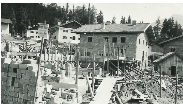
Bau der sogenannten Südtirolersiedlung. © Stadtarchiv St. Johann/Pg.
